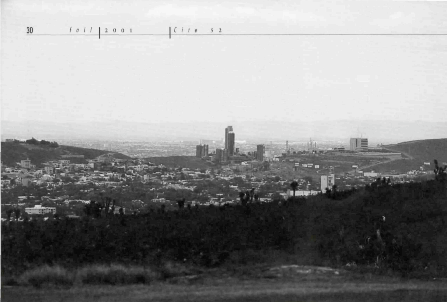
Valle Oriente, San Pedro Garza García. The tallest building is the Torre Dataflux (2000, Agustín Landa).
